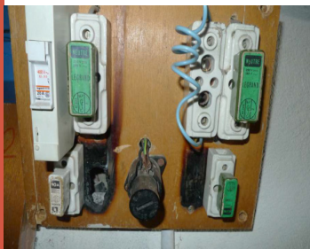
Branchements d'électricité vétustes
