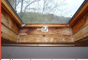
Absence de protection contre les infiltrations d'eau
