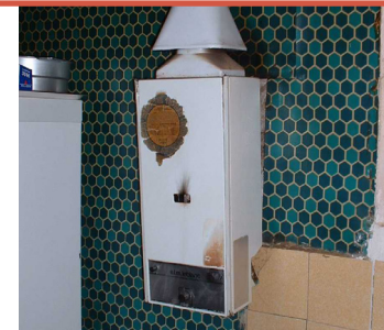
Absence de dispositif d'évacuation des gaz brûlés
