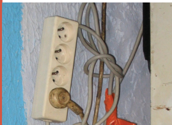
Installation électrique dangereuse
